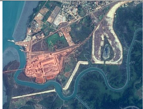
Image SPOT6 à 1,5 m, (CN), 2015, Chantier - Kamsar (Guinée maritime).
